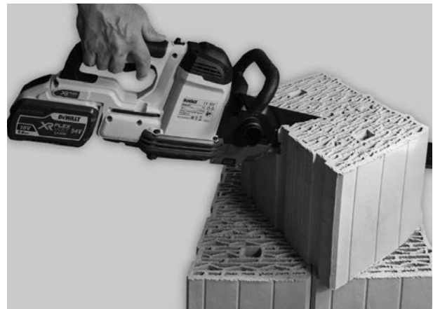
Beidseitig Führungsnuten einsägen
